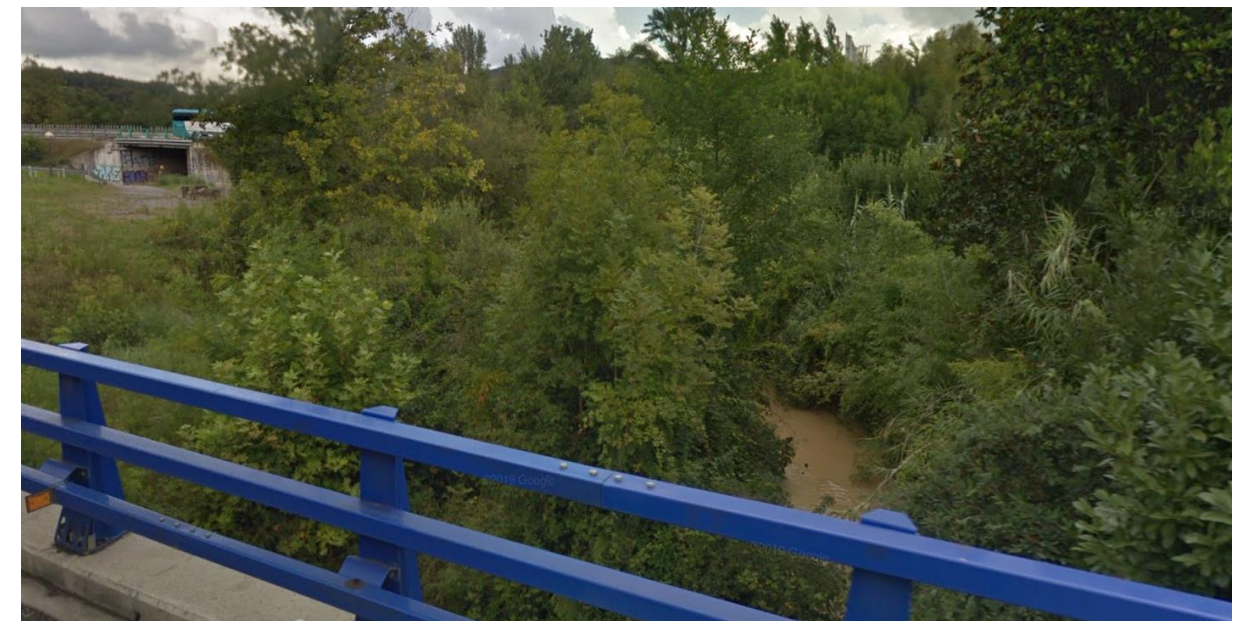
Arroyo Oromiño en las proximidades del cruce de la N-634 al fondo se ve la zona del cájon de paso de la carretera vecinal bajo la autopista. Zona que será cruzada hasta la margen contraria del arroyo en estructura.
